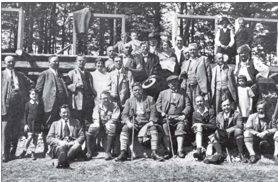
Vsetínští turisté při výstavbě chaty na Vsackém Cábu v r. 1927
