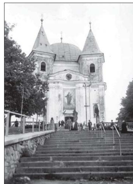
Poutní kostel na Hostýně v r. 1931 Foto K. Puszkailer
