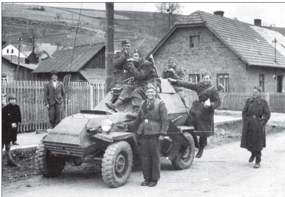
Příjezd motorizované jednotky IV. čs. armádního sboru do Hošťálkové 5. května 1945 Foto R. Pavlík
