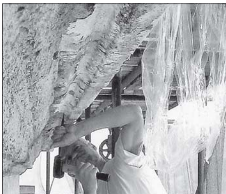
Akad. soch. M. Machala při opravě kamenné římsy Foto M. Ošťádal
