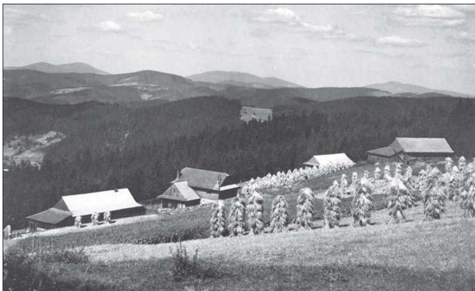
Kasárna - útulna KČT na hřebeni Javorníků
