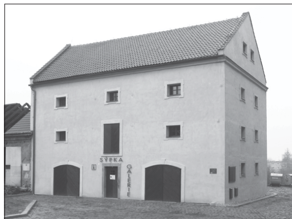
Sýpka po rekonstrukci, 2006
