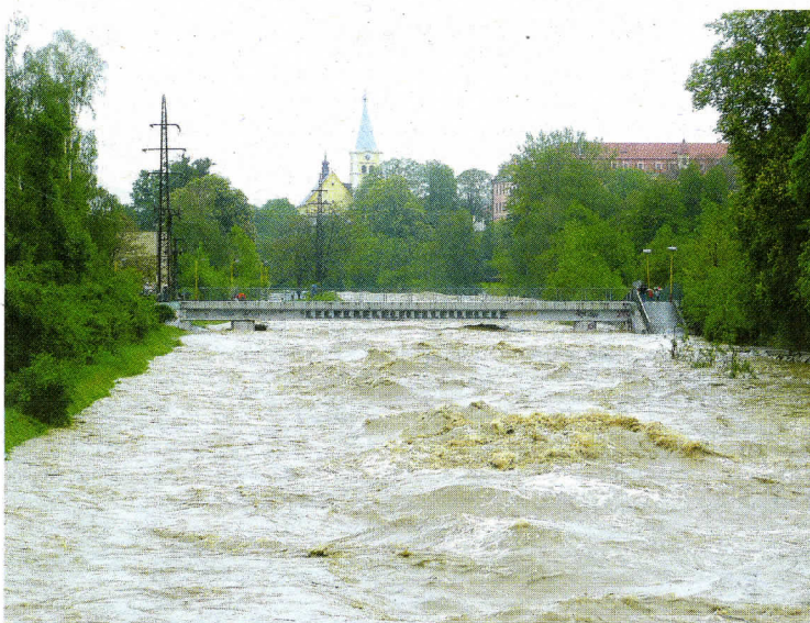
Voda tekoucí úzkým a rovným betonovým korytem má při povodni mnohem ničivější sílu (povodně ve Valašském Meziříčí 2009). Foto: Muzeum Valašsko
