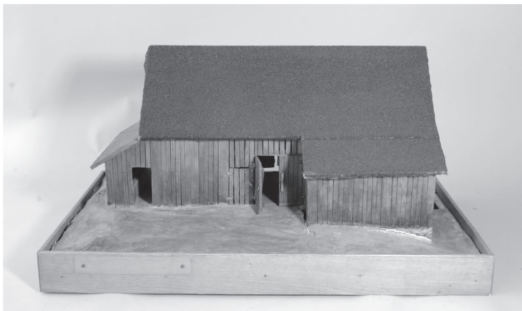
Obr. 4: Model příčné průjezdné stodoly s kamennou podezdívkou a deštěnými stěnami. V boční stěně vchod do sklepa. Vrata laťová zavěšená na kožených poučkách. Sedlová střecha kryta šindelem a térovým papírem, na přístavcích střecha pultová. Budova je umístěna na obdélníkové podložce - sádrou vyplněném dřevěném rámu. Inv. č. E 20179. Foto Gabriela Skyva Dobešová, fotoarchiv MJVM.
