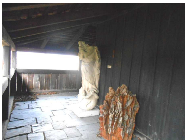
18. Rozvolněná kamenná dlažba ochozu
