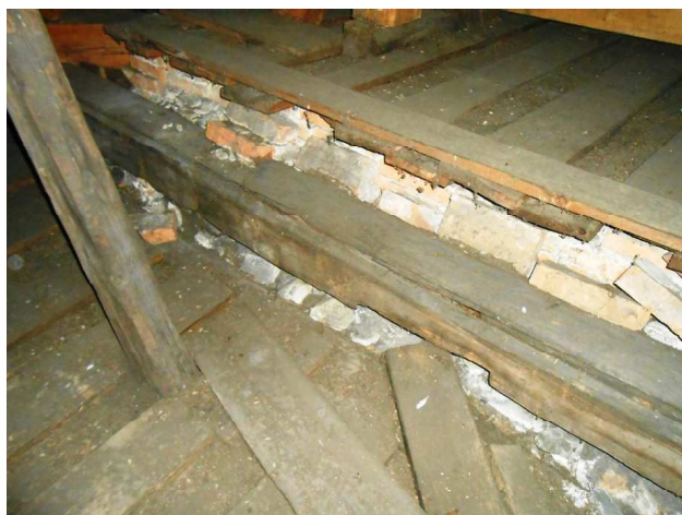
13. Rozvolněná nadezdívka vítězného oblouku, uvolněné konstrukce dřevěného stropu v půdním prostoru
