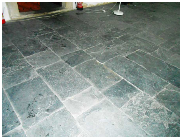
17. Zdeformovaná kamenná dlažba presbytáře
