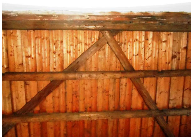
14. Odkrytý trámový strop nad hlavní lodí se zbytky hřebíků v trámech
