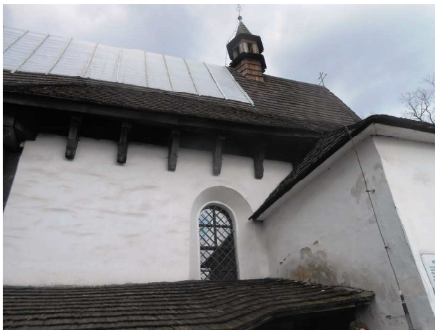
4. Zakrytí porušené střechy fólií v roce 2015, degradované omítky kaple nad ochozem
