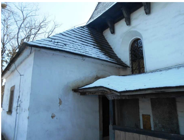
6. Degradované omítky sakristie nad ochozem
