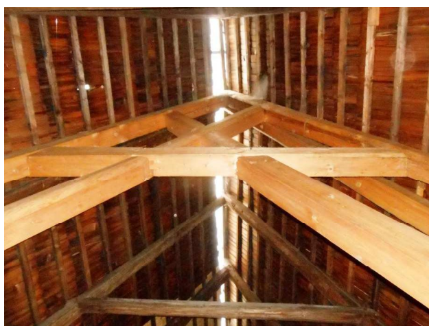
11. Plná vazba nad presbytářem z nového dřeva, odkrytí hřebene
