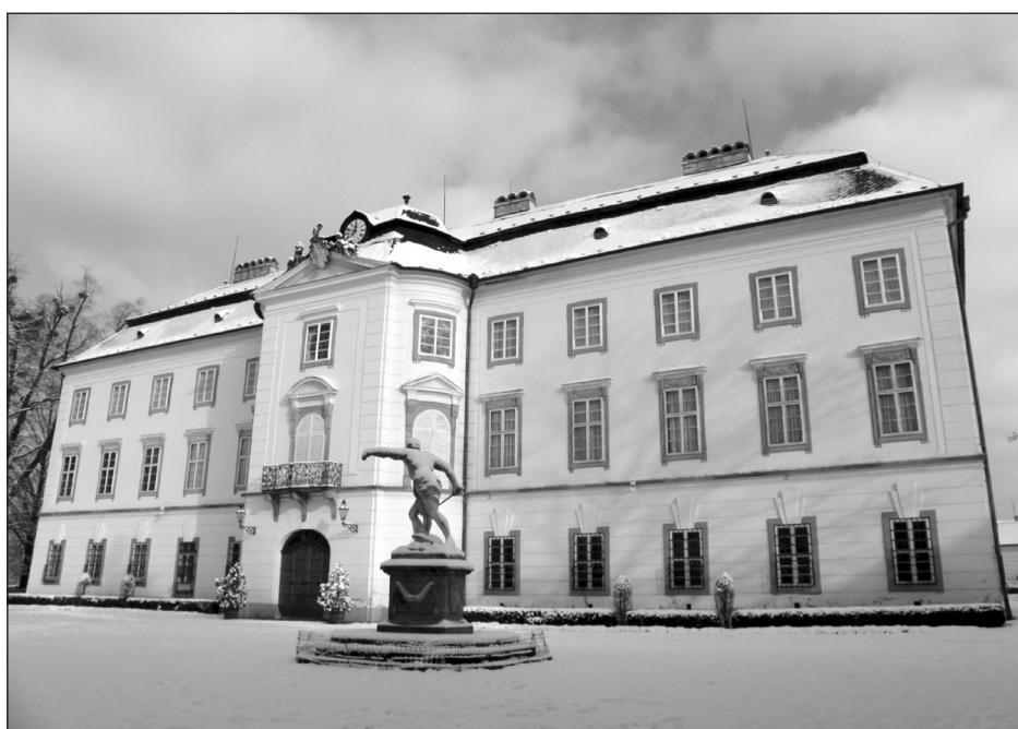
Pohled na západní křídlo zámku Vizovice
