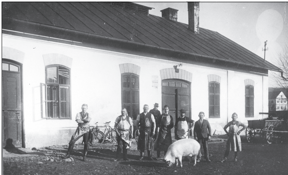
Budova společné porážky vsetínských řezníků na Trávníkách kolem roku 1920 Foto archiv MRV ve Vsetíně
