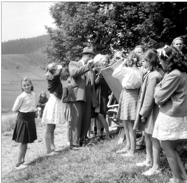
■ Usazení těžké konstrukce kopule na hrubou stavbu hvězdárny v létě roku 1949 vyžadovalo poměrně velkou přesnost.
