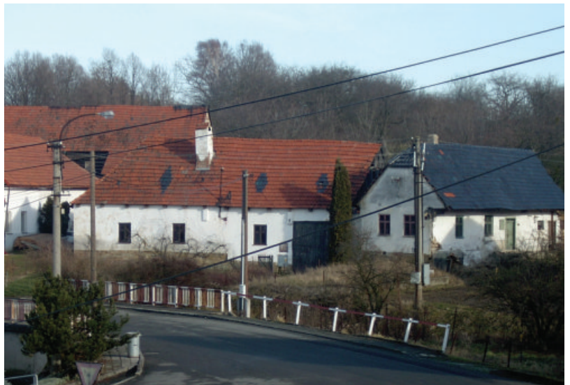
Babice u Kelče, usedlosti čp. 7 (vlevo) a původní čp. 8 (vpravo) před rekonstrukcí, patrný je náznak původní střešní krajiny. (Foto Radek Bryol, 2008)
