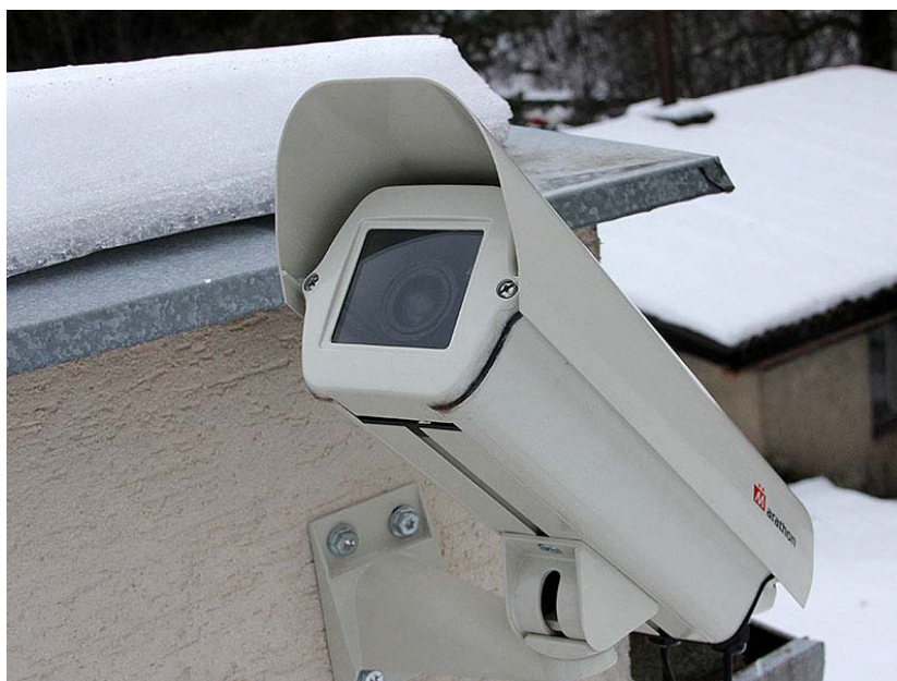
Umístění kamery na střeše Hvězdárny Vsetín.
