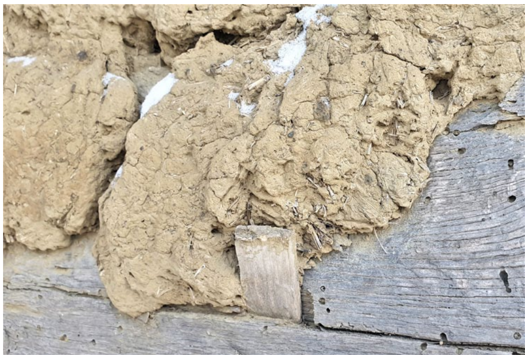
Obr. 10: Detail přichycení tzv. „kožichu“ – hlíněné mazaniny na dřevěných trámech domu čp. 18. Foto Z. Krajcar. |
