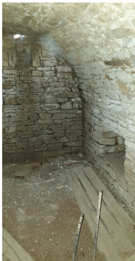
Obr. 5: Prostorný kamenný sklep domu čp. 18, přibližně v délce i v šířce síně, umístěné nad ním. Foto Z. Krajcar.
