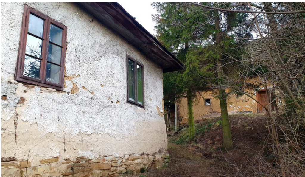
Obr. 3: Soubor raritních roubených domů v „kožichu“ (čp. 19 – vlevo a čp. 18 – vpravo) v těsné blízkosti u sebe. V pravé části před domem – hmota původní fortifikace, valu slavkovské tvrže. Foto Z. Krajcar.
