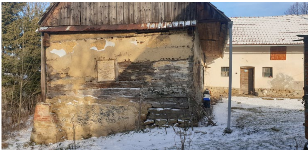
Obr. 6: Pohled na roubený dům čp. 18 z jihu západu se zbytky „kožichu“. V pravé části navazuje novodobější chlév. Foto Z. Krajcar.
