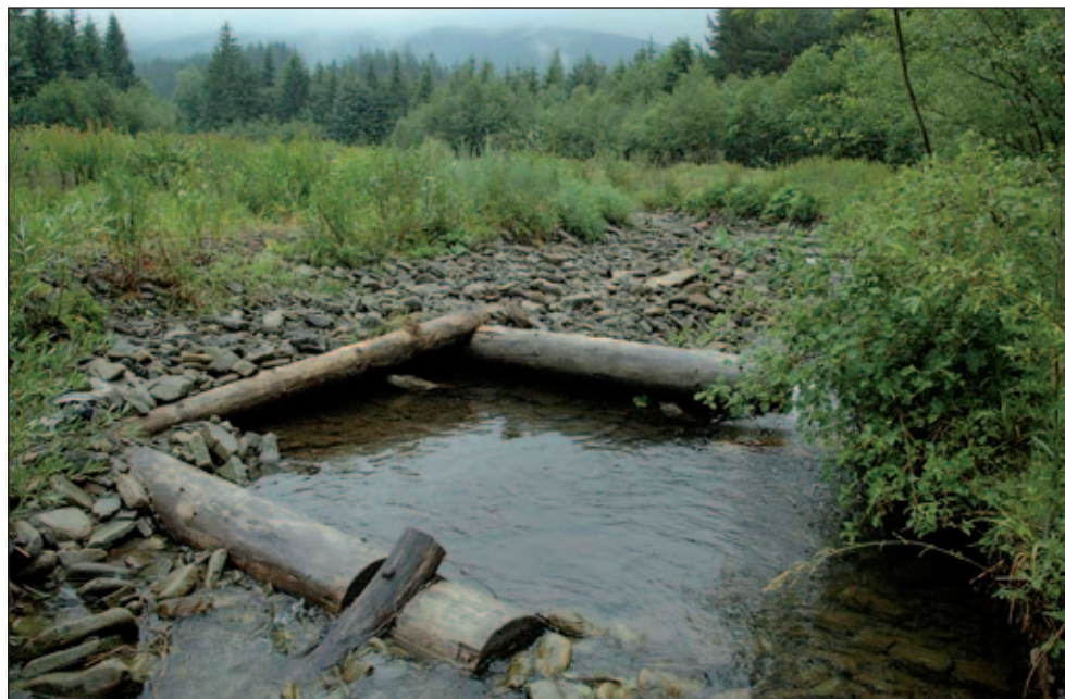
Obr. č. 2: Provedená stabilizace hlavního koryta Kněhyně se značným objemem zachyceného štěrku ve střední části revitalizované plochy (červen 2014, foto Marek Banaš).
